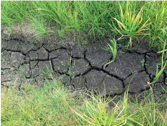
Abb. 5.6.: In einer Fahrspur sind tiefe Risse im Torf erkennbar. Foto: ©G.L. Constantin
