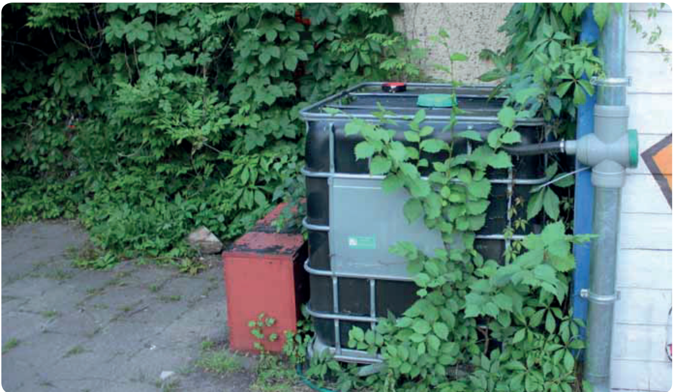
IBC-Tanks fassen 1000 Liter Wasser und können – soweit sie aus der Nahrungsmittelindustrie stammen – als Regenwasserauffanganlage sinnvoll wiederverwendet werden (Foto: Eva Foos. Maxim Kinder- und Jugendkulturzentrum, Berlin).
